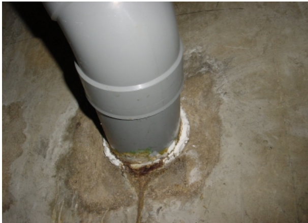
Conduit de fluide (eau) n° 31, souche noyée maçonnerie
