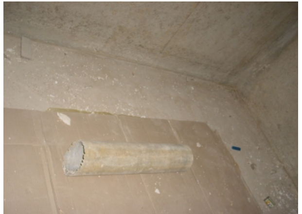
Conduit de fluide (eau) amiante ciment
