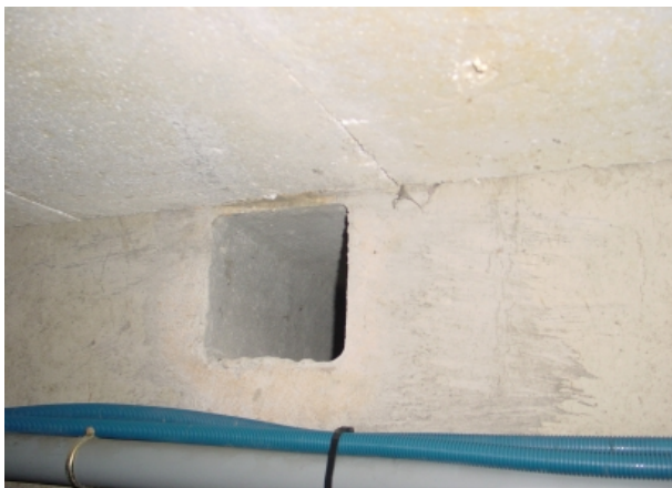
Conduit de fluide (air) amiante ciment section carré
